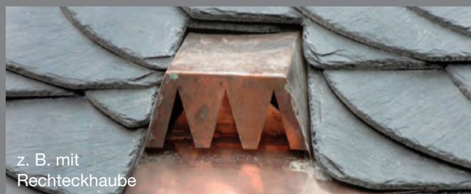
Dachfirstentlüfter mit Schnee- und Insektenschutz (Vlies)
